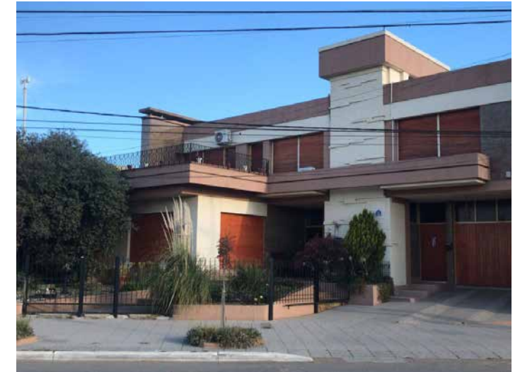
Vivienda Sr. CAVASSA. (Av. Zeballos 311) . 12
