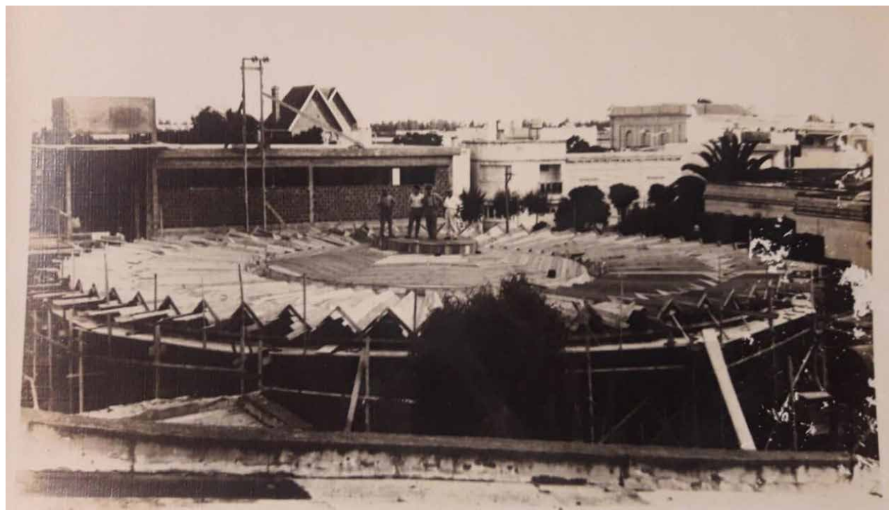
Foto de la terminal de General Pico (encofrado de la cubierta de Hormigón Armado). Circa 1960.
