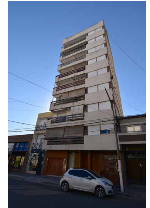
Imagen actual del edificio de Calle 25 de Mayo.
