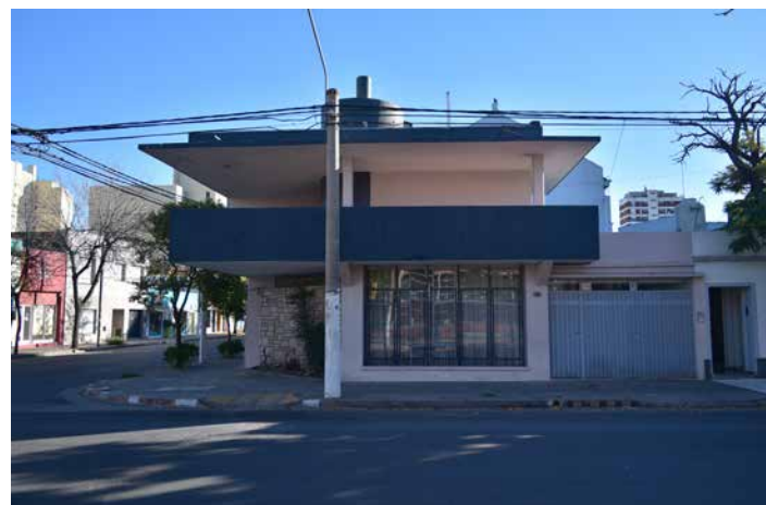
Vista actual de la vivienda de Lisandro de la Torre esquina 25 de Mayo.
