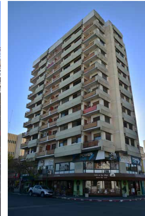
Vista actual del edificio "PAMPA" (Gil esquina Avenida San Martín)
